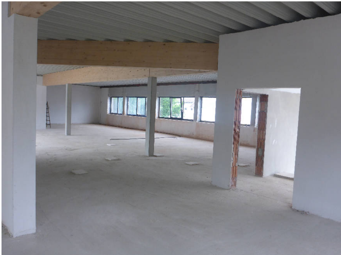
Bild 04 / West-Etage (noch im Rohbau)
