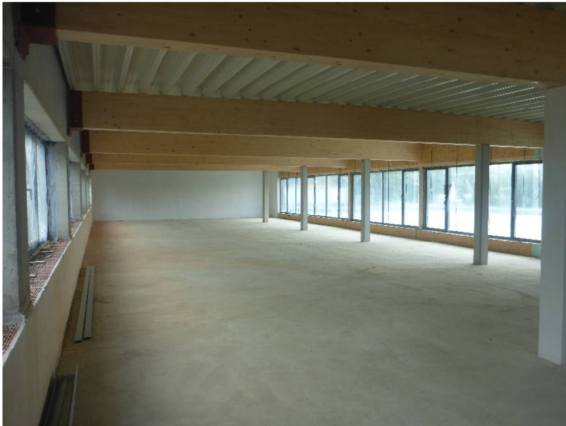
Bild 03 / Ost-Etage (noch im Rohbau)
