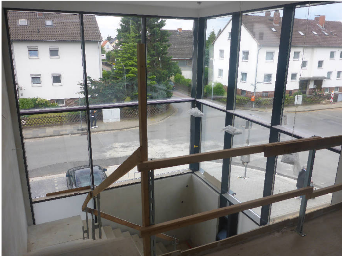
Bild 02 / Blick aus dem noch im Rohbau befindlichen Treppenhaus
